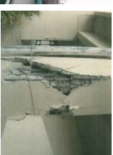
東北大学(柱の崩壊)
