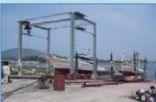
岸壁等の軽劣化施設
