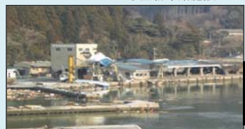
荷捌き施設と製氷施設
